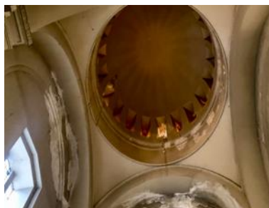
Foto 13. Cupola fotografiată din interior
